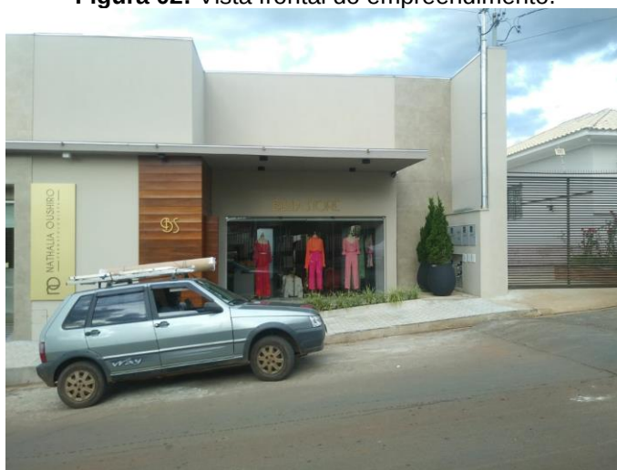
Figura 02: Vista frontal do empreendimento.
